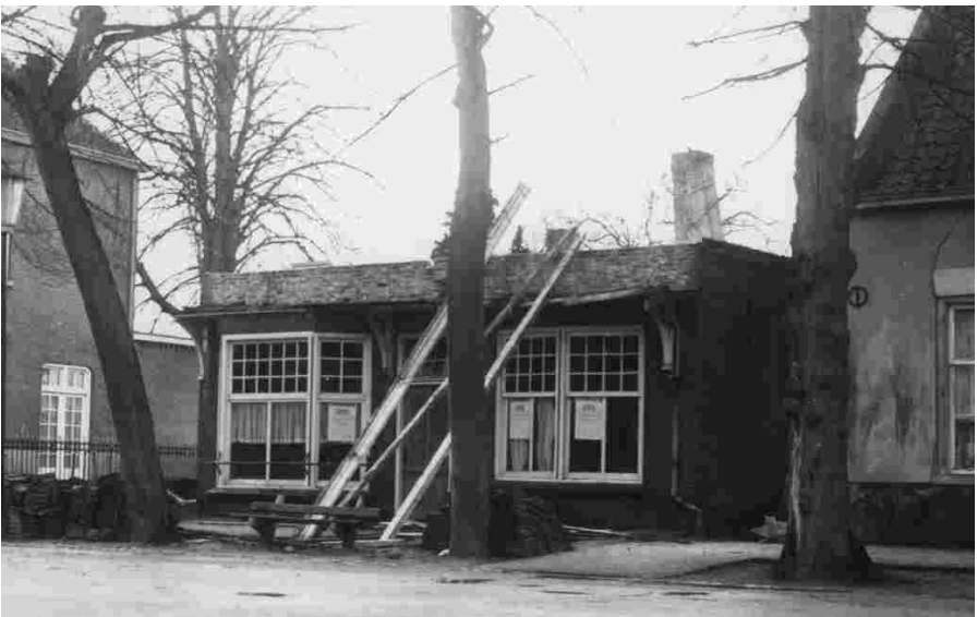
Voormalig pand van N. Jacobs tijdens de sloop. (coll.Rd)
