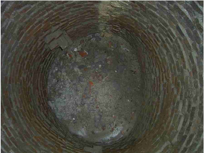
Fig. 2 De binnenzijde van de nog bestaande waterput
