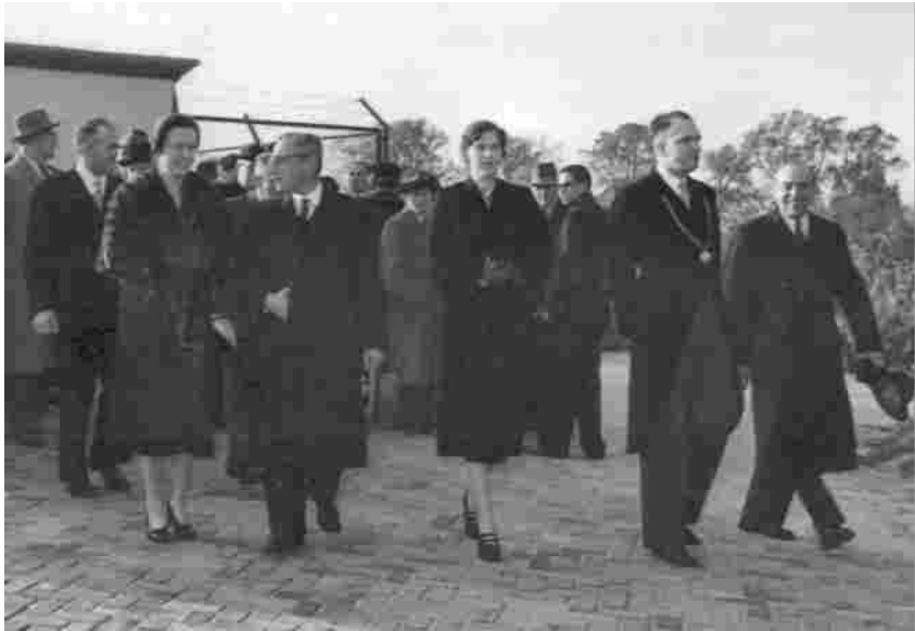
Opening van de nieuwe propaangasinstallatie door de Commissaris van de Koningin de Quay en burgemeester Ballings
