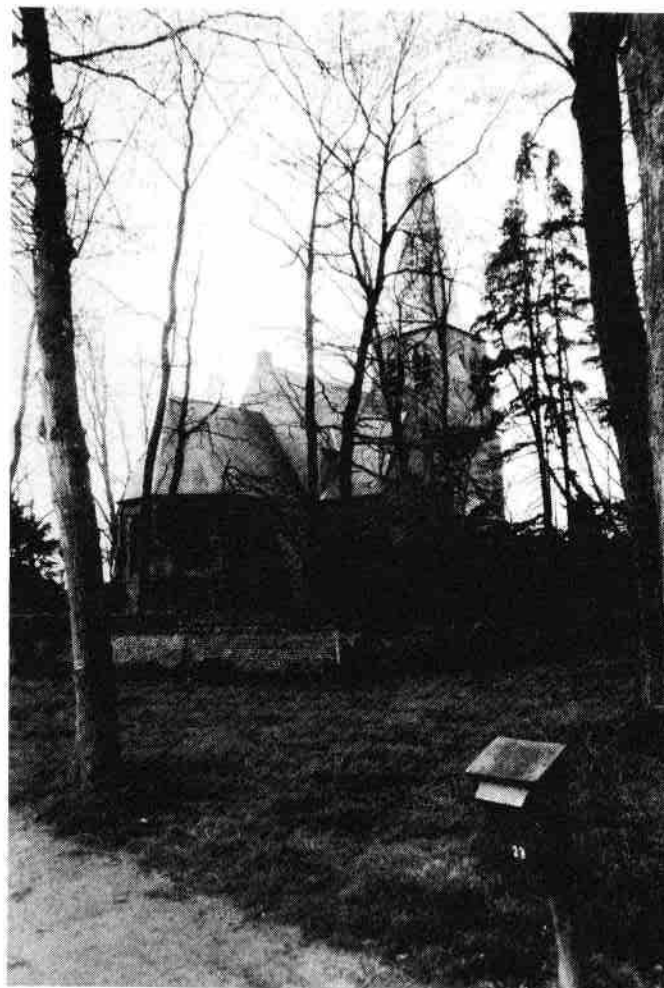
Figuur 2. De kerk gezien vanuit het noord-oosten, omringd door de kerkhofmuur en het geboomte.
