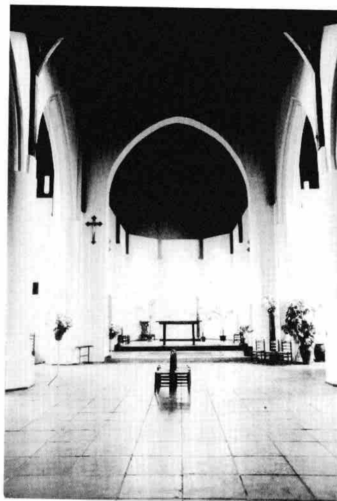
Figuur 7. Doorkijk door het schip naar het koor. Alle delen van de ruimte zijn met een houten tongewelf afgedekt.
